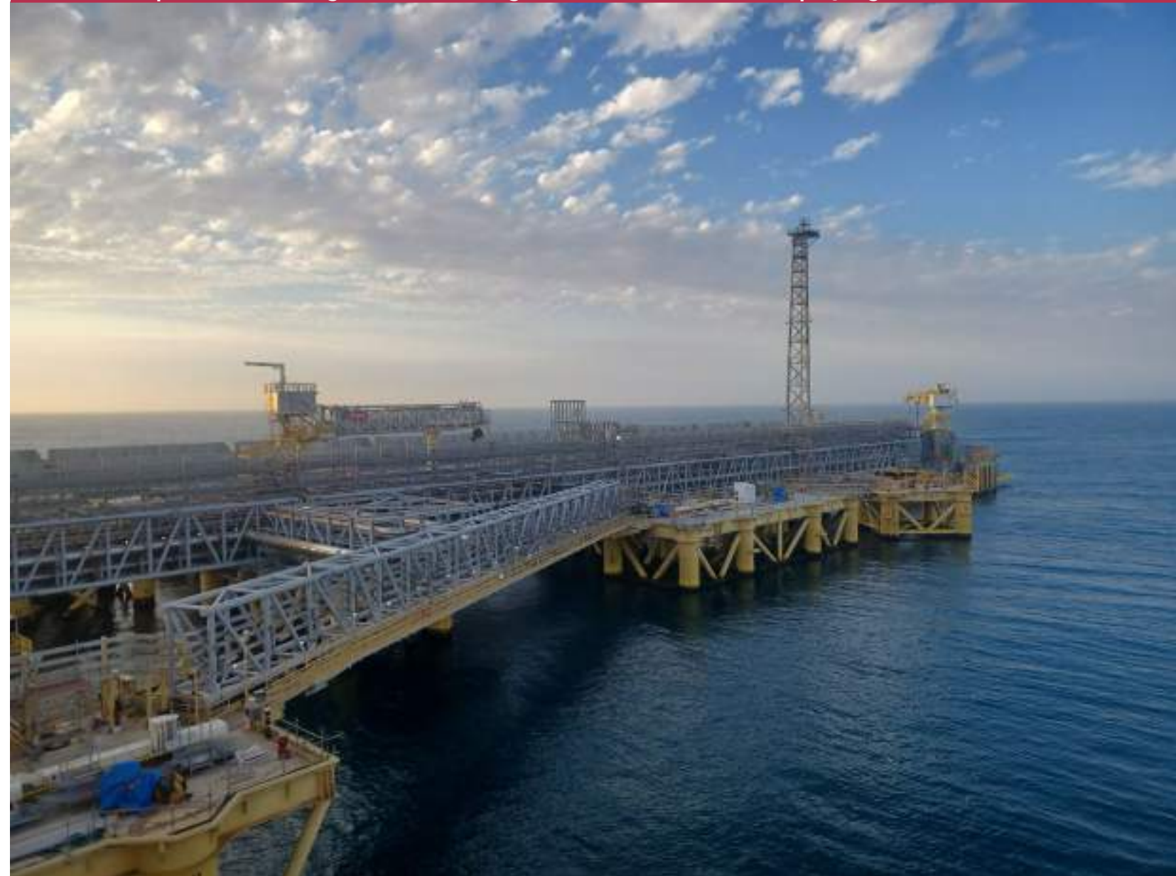
Installations portuaires au large des côtes sénégalaise et mauritanienne du projet gazier offshore GTA
